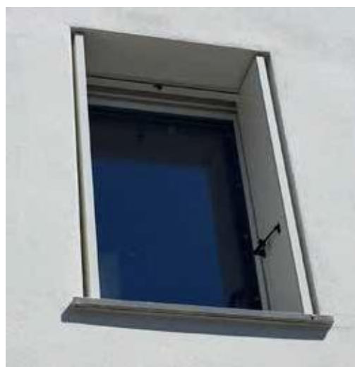
Particolare di PIEGA in apertura
